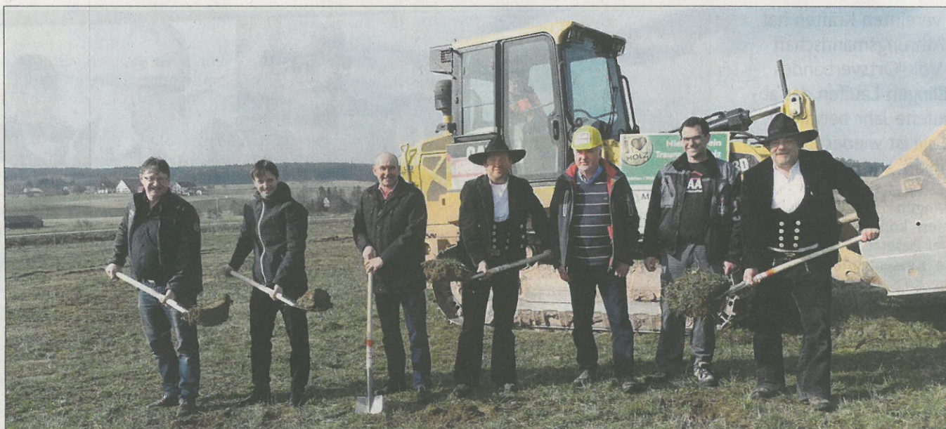
Gutgelaunter Beginn der Bauarbeiten (von links) Wolfgang und Florian Haas (Firmeninhaber), Vertriebschef Georg Behr, Ronald Dreher (Bauleiter der Zimmerei Haller), Manfred Krachenfels von der Firma Efinger (Erdarbeiten), Rainer Haas (Betonarbeiten) und Markus Haller.
